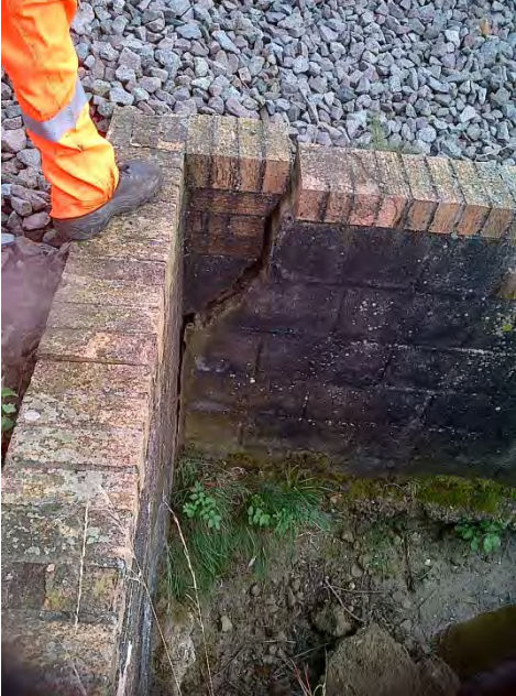
D10 - Culvert 2479.6m – 2500m (93M 142y – 93M 164y)
