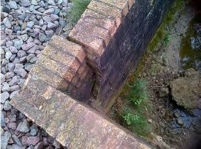
D12 - Culvert 2479.6m – 2500m (93M 142y – 93M 164y)
