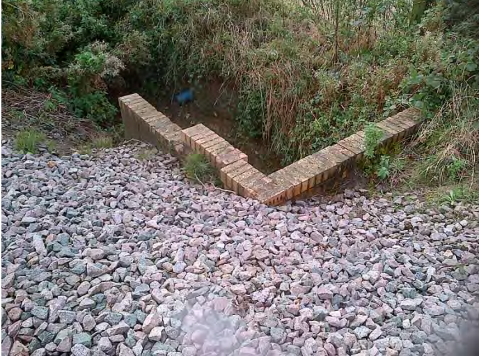
D11 - Culvert 2479.6m – 2500m (93M 142y – 93M 164y)
