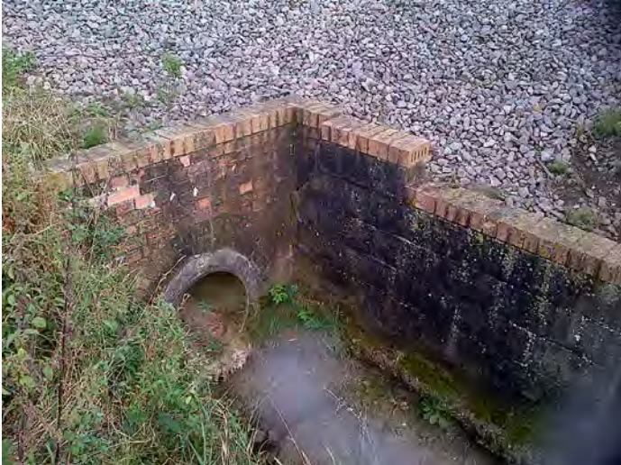
D9 - Culvert 2479.6m – 2500m (93M 142y – 93M 164y)
